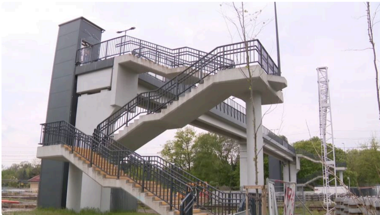
Kładka w Łodzi w ciągu ulicy Srebrzyńskiej
